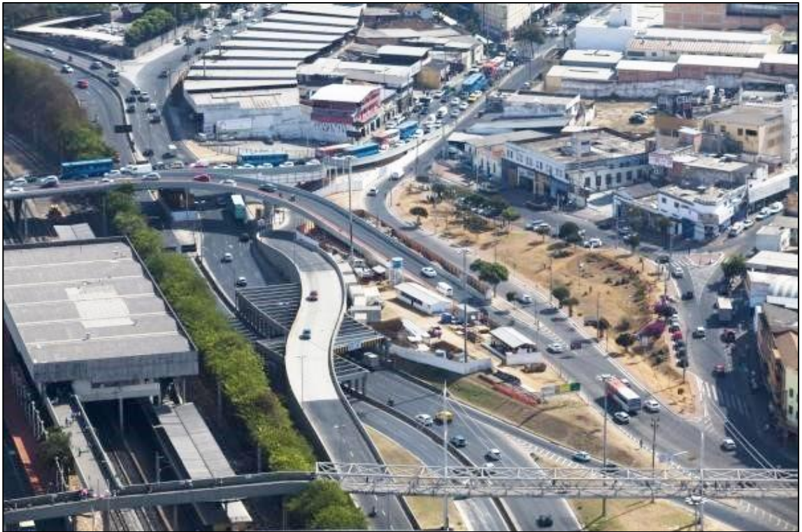
IMAGEM 9 - Construção do Complexo viário da Lagoinha em 1984
